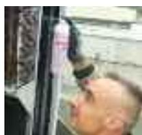
J'utilise le produit détecteur de fuites gazeuses en aérosol pour localiser précisément les fuites de fluide frigorigène. Les détecteurs électroniques ne permettent qu'une localisation grossière. L'avantage d'IBIOTEC DETECT 1000 est que la pression reste disponible, même si l'aérosol est resté dans une température ambiante basse. Le détecteur de fuites que j'utilisais avant avait du mal à sortir de l'aérosol lorsqu'il faisait froid, et il y avait très peu de bulles.
